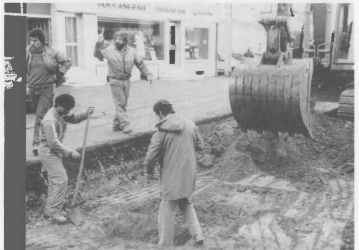
Travaux rue de Ham (RL)
