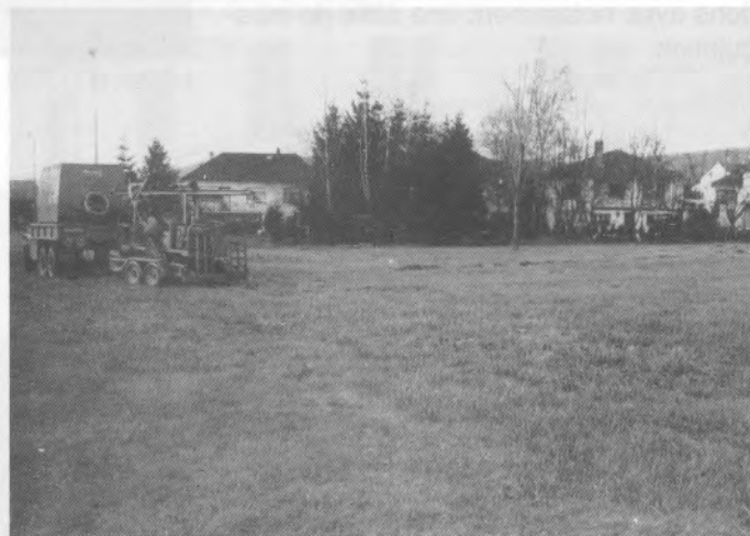
Etude du sol pour le court couvert de tennis
